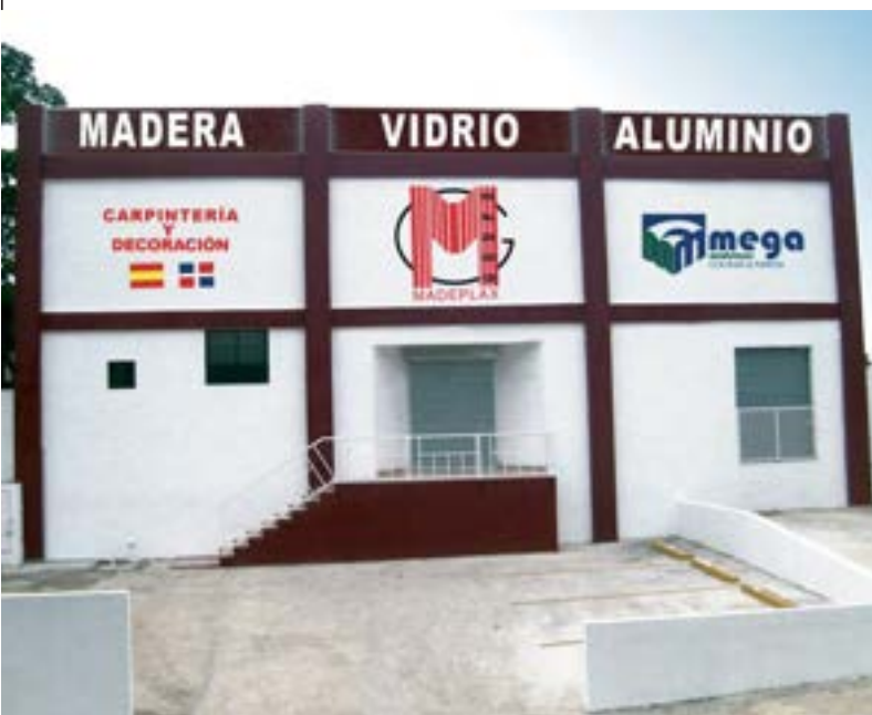
Oficinas y almacén de Megamodulares, ubicada en Calle Palmiche N° 1, Cerros de Palmarejo, a la altura del Km. 17 de la Autopista Duarte, Santo Domingo - República Dominicana.
