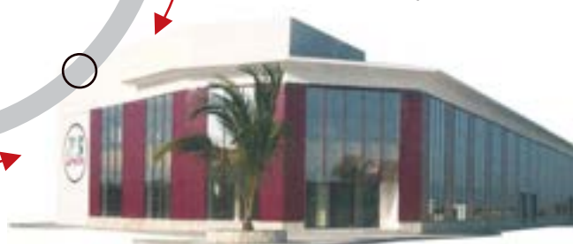
NUEVAS INSTALACIONES DE MONCTON - 3 CENTER
