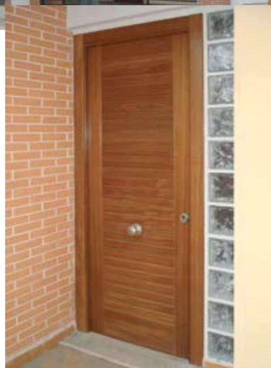
▲ Puerta de entrada maciza machihembrada fabricada en madera iroko, ideal para construcciones de diseño arquitectónico moderno basado en líneas rectas.
